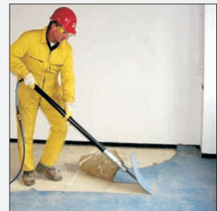
Lösen von weichen Bodenbelägen
