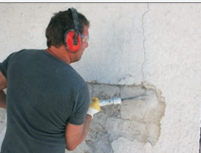
Abschlagen von Aussenputz
