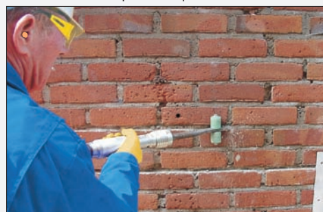
Räumen von Fugen in gleichbleibender Tiefe
